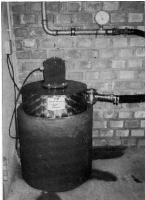
*Kleinstwasserkraftwerk „Kaufmann KWP300“ zur Ladung der Batterie*
