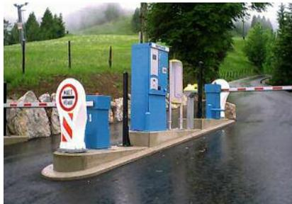
Dauernutzer wie Eigentümer, Lieferanten und Holztransporter beispielsweise das Recht vergeben werden, die Schranken bequem mittels Dauerkarte oder RFID-Transponder, ticket- bzw. berührungslos zu öffnen und anschließend zu durchfahren. Damit wird den Dauerkartenbesitzern ein besonderer Service zuteil, die diese Straße wahlweise kostenlos oder über eine Monats- oder Saisongebühr befahren können. Hierfür werden die Daten des
