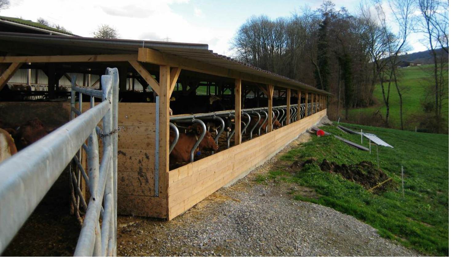
Aufgrund der klimatischen Bedingungen und der Kostensituation wurde am Sonnberghof der Familie Zimmermann sehr einfach gebaut.
