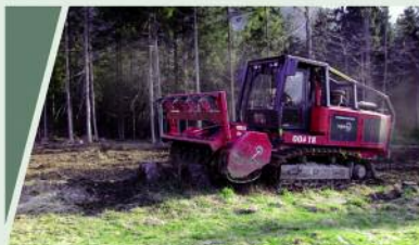
Wurzelstockrodungen: Bagger mit Roderechen und Forstmulcher
