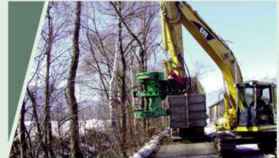
Baum- und Strauchrodungen mit Bagger und Zwickel: Materialübernahme möglich
