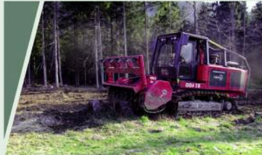
Wurzelstockrodungen: Bagger mit Roderechen und Forstmulcher
