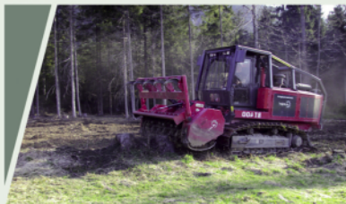
Wurzelstockrodungen: Bagger mit Roderechen und Forstmulcher
