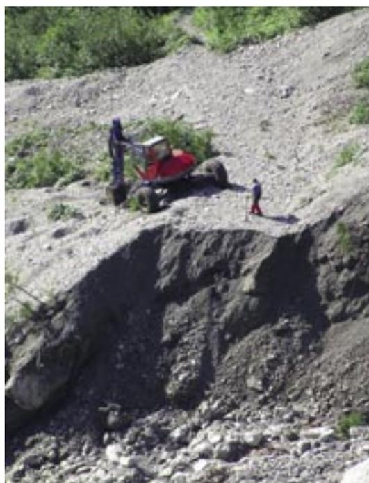
Der einzige Zugang zur Saxenalm wurde von einer Mure bis zu 7 Meter tief weggerissen.
