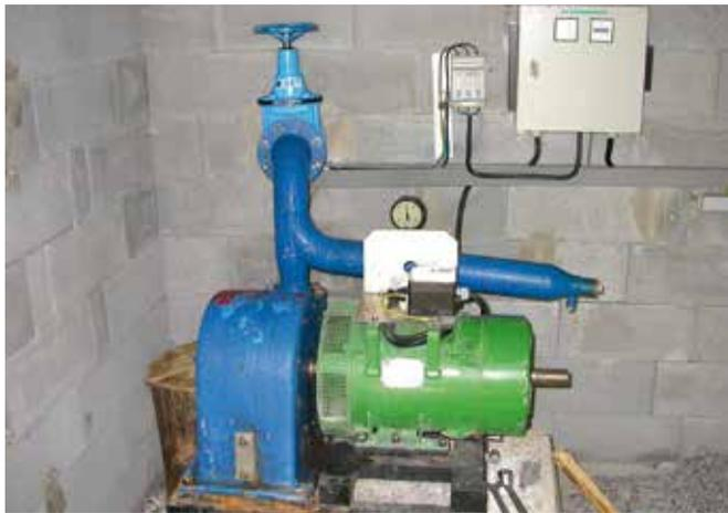
Abbildung 47: Turbine und Generator eines Kleinwasserkraftwerks (© Stefan Hellebart)
