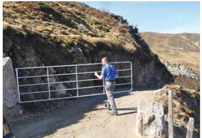
Abbildung 111: Breitenverstellbares Alu-Drehtor (© Norbert Kerschbaumer)
