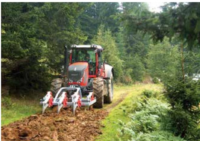
Abbildung 12: Reißzähne bearbeiten eine Weganlage. (© Friedrich Walter Merlin)
