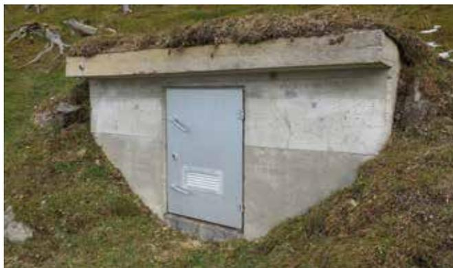
Abbildung 55: Ein betonierter Quellschacht (© Stefan Hellebart)
