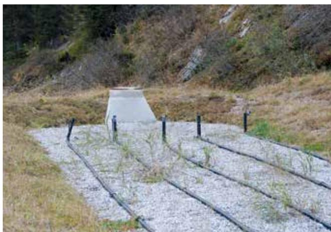
Abbildung 87: Neu errichtete Pflanzenkläranlage auf einer Alm
