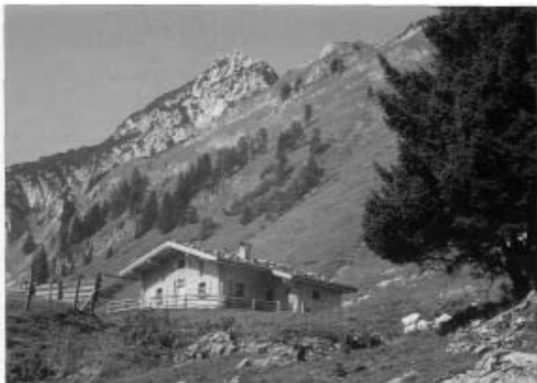
Gebäude aus herkömmlichem Material sind wieder gefragt
