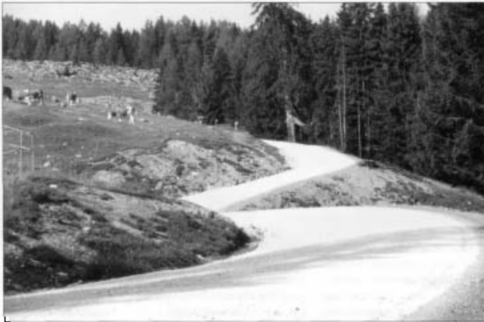
Der Weg zur Kögl-Alm in der Gemeinde Langkampfen wurde auf einer Länge von 2,8 km errichtet
