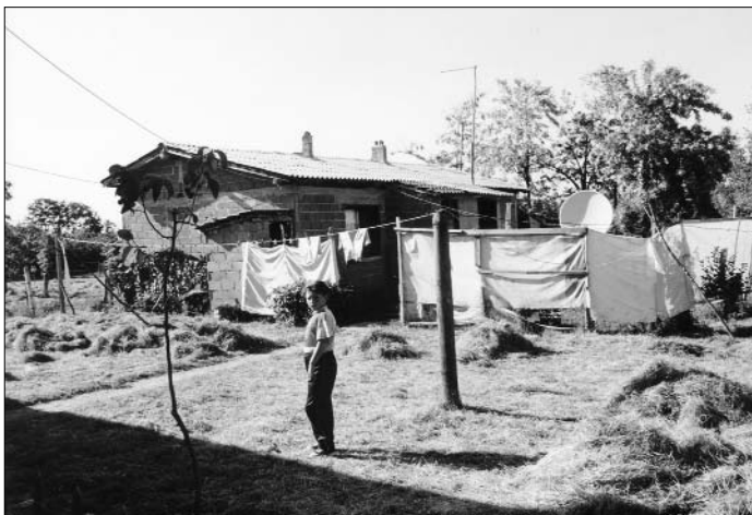
Eines der wiederaufgebauten Wohnhäuser der Großfamilie Gashi. Im Krieg 1999 wurden Häuser und Hof fast vollständig zerstört
