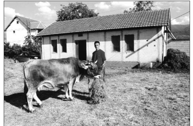
Im Rahmen des Stallbauprogramms der Caritas Schweiz als Ausbildungsobjekt gebaut: der Stall von Arsim Gashi
