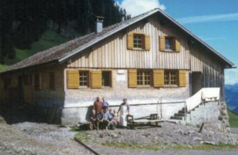
Die renovierte Alphütte mit der Bewirtschafterfamilie von 2002. Alle nötigen modernen Betriebseinrichtungen konnten in den bestehenden Räumlichkeiten untergebracht werden
