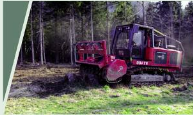
Wurzelstockrodungen: Bagger mit Roderechen und Forstmulcher
