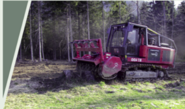
Wurzelstockrodungen: Bagger mit Roderechen und Forstmulcher
