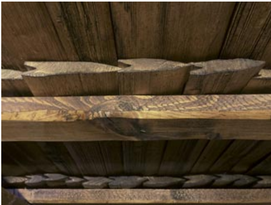
Die Riesengebirgsschindel ist an den Längsseiten zugespitzt und wird in den Deckreihen seitlich gesteckt.
