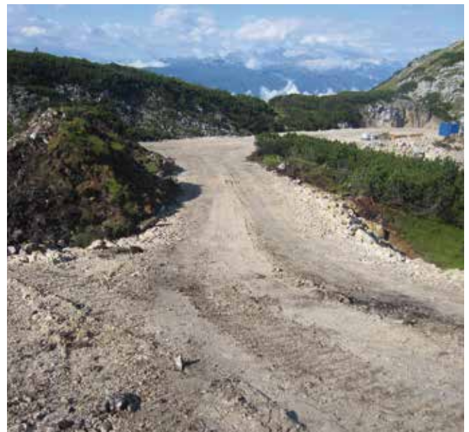
Abbildung 68: Der wertvolle Oberboden muss im Rahmen von baulichen Maßnahmen unter allen Umständen erhalten werden. (© Bernhard Krautzer)
