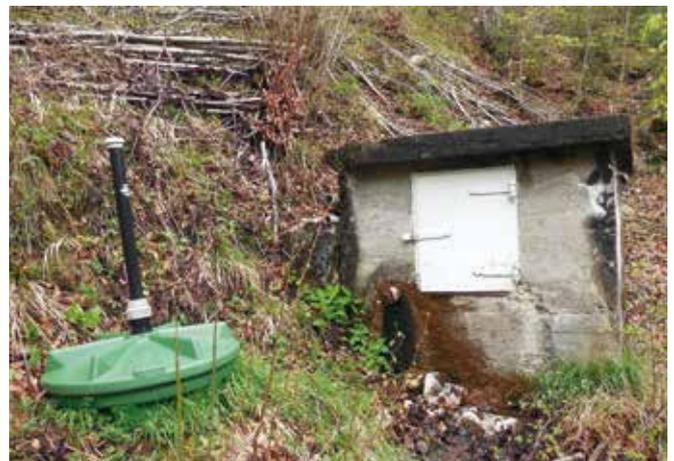
Abbildung 6: Ein betonierter Quellschacht und ein Quellschacht in Kunststoffausführung (© Stefan Hellebart)
