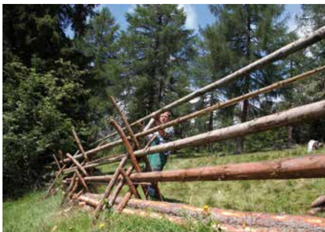
Abbildung 7: Beim Steckzaun kann oft Material verwendet werden, welches im umliegenden Wald zu finden ist. (© Gerhard Mader)
