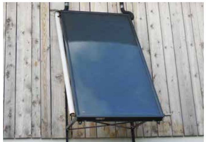
Abbildung 52: Mit einem Sonnenkollektor kann warmes Wasser gewonnen werden; in einem Boiler wird das warme Wasser gespeichert. (© Stefan Hellebart)
