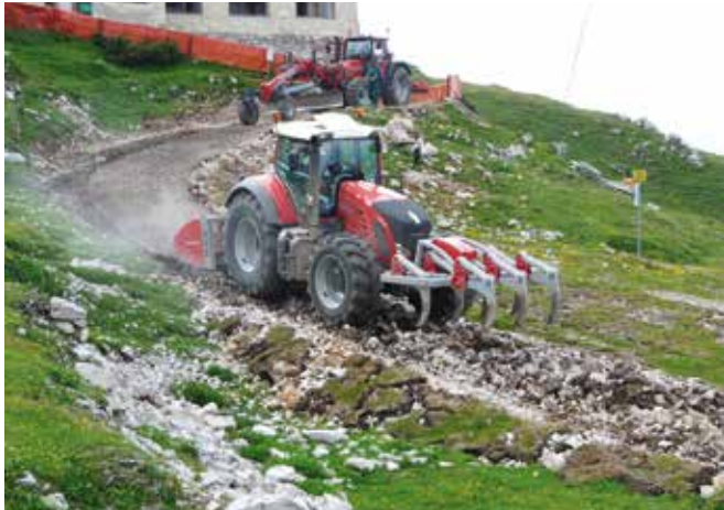
Abbildung 11: Almwegesanieierung durch Großgeräteinsatz (© Friedrich Walter Merlin)
