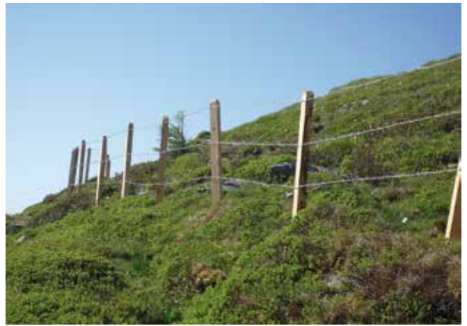
Abbildung 102: Holzpfähle (© Josef Obwegger)
