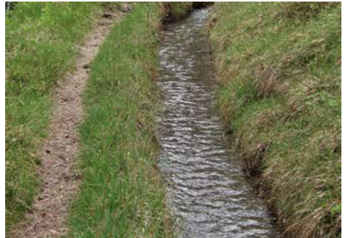
Abbildung 74: Zuleitungsgraben oder Waal (© Stefan Hellebart)
