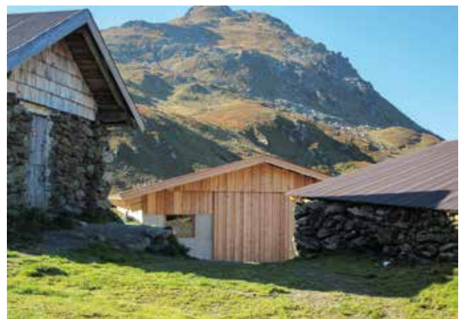
Abbildung 17: Neuer Almstall neben alter Bausubstanz (© Peter Rainer)
