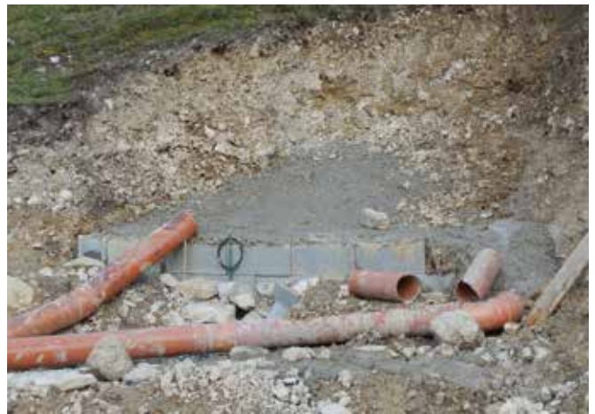
Abbildung 57: Das Fassen einer Quelle auf einer Alm; über Beton und Mauerwerk wird noch ein Lehmschlag aufgebracht, um das Eindringen von Oberflächenwasser zu verhindern. (© Stefan Hellebart)
