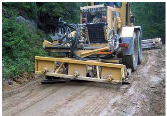
Abbildung 15: Rüttelplatten verdichten die Weganlage. (© Friedrich Walter Merlin)
