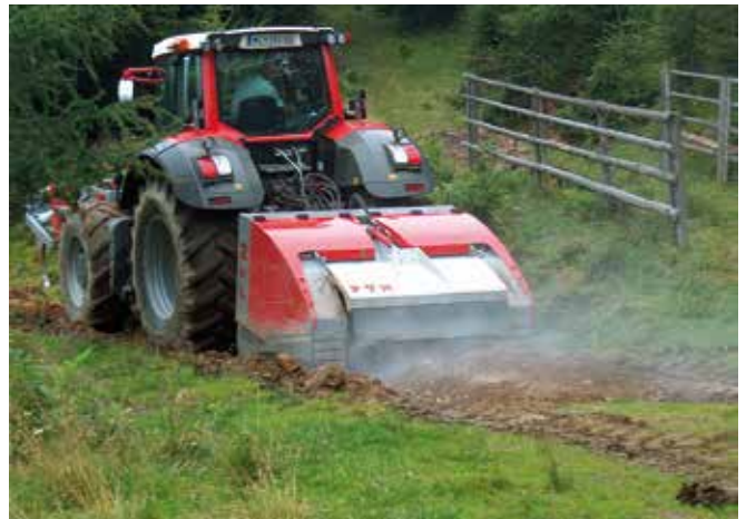
Abbildung 13: Fräsen einer Weganlage (© Friedrich Walter Merlin)
