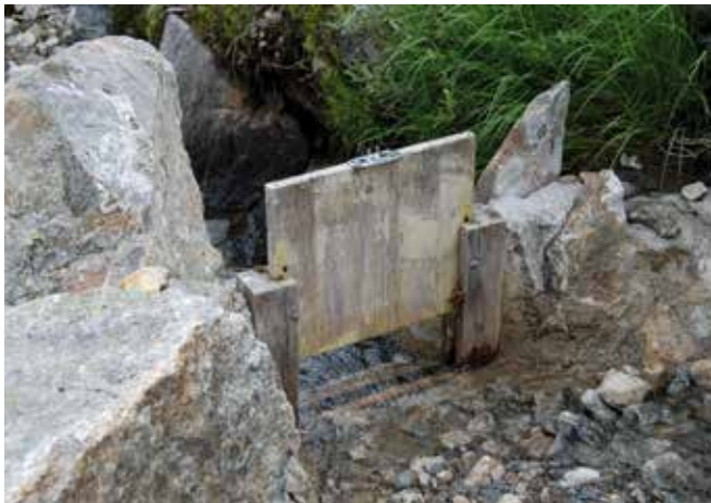
Abbildung 73: Ein Einlauf zu einem Zuleitungsgraben (© Stefan Hellebart)
