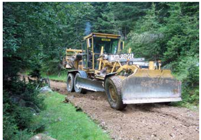
Abbildung 14: Grädern einer Weganlage (© Friedrich Walter Merlin)
