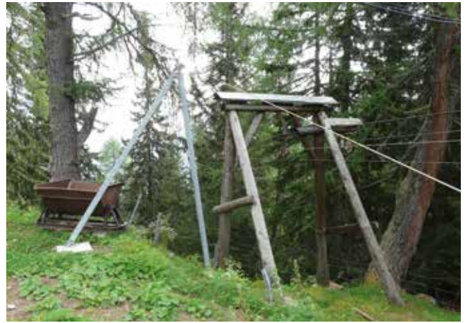
Abbildung 5: Seilbahnanlage, Bergstation © Friedrich Walter Merlin
