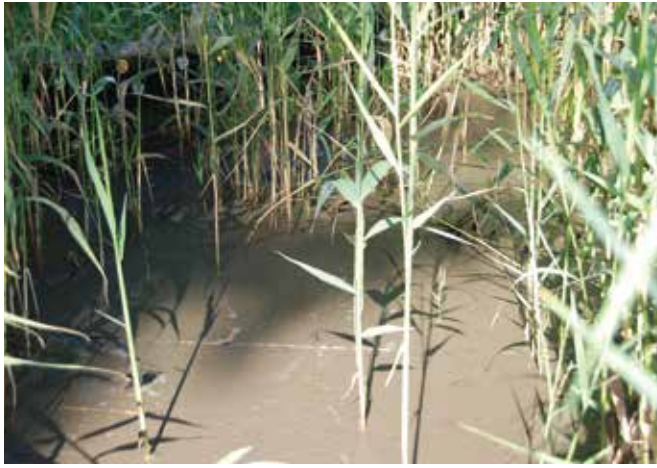
Abbildung 84: Pflanzenkläranlage (© Stefan Hellebart)
