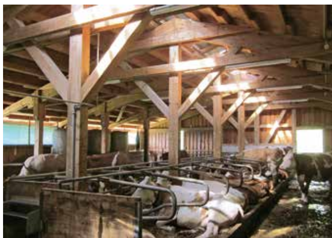
Abbildung 21: Liegeboxenlaufstall mit Tiefboxen, Bundwerk mit Koppelpfetten (© Peter Rainer)
