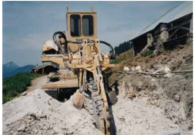
Abbildung 45: Fräsmaschine zur Verkabelung einer Stromleitung (© Kurt Egger)
