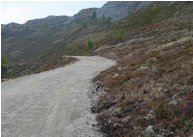
Abbildung 9: Almweg mit Schottertragschicht (© Friedrich Walter Merlin)
