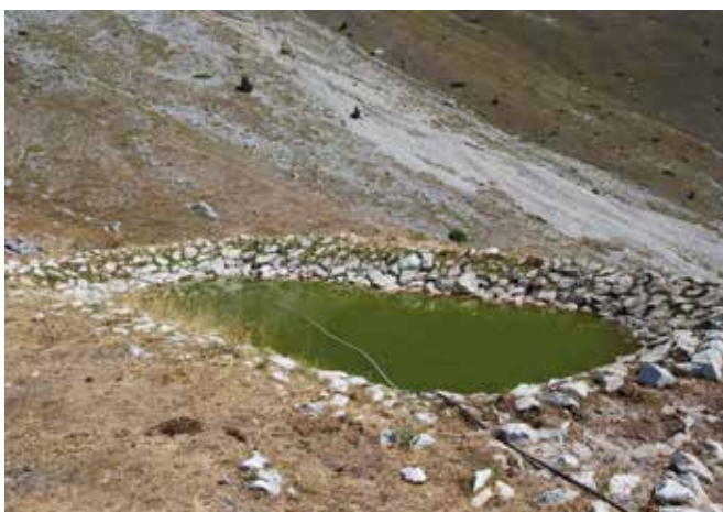
Abbildung 61: Wasserspeicherung mittels einer offenen Zisterne; durch den Lichteinfall kann es im Wasser zu Algenbildung kommen. (© Stefan Hellebart)
