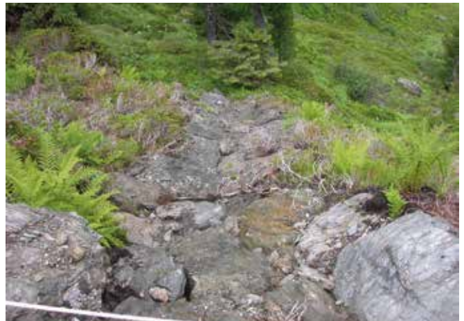
Abbildung 85: Das Niederschlagswasser von Weg- und Hofflächen wird durch ein Raubettgerinne geleitet – dadurch sollen Erosionen an der talseitigen Böschung vermieden werden; das Niederschlagswasser wird, im Gelände verteilt, zur Versickerung gebracht. (© Stefan Hellebart)
