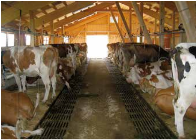
Abbildung 28: Anbindestall mit Güllerost (© Robert Schwaninger)
