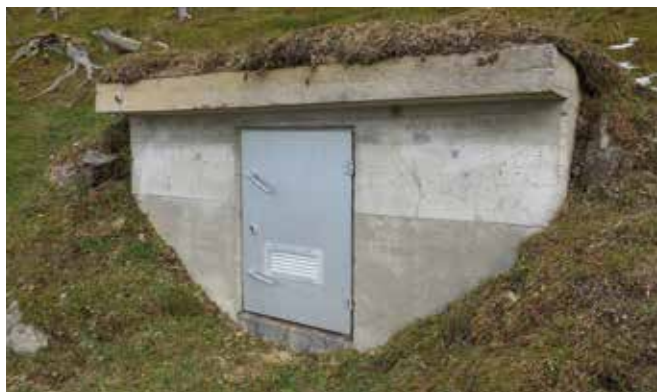
Abbildung 55: Ein betonierter Quellschacht (© Stefan Hellebart)
