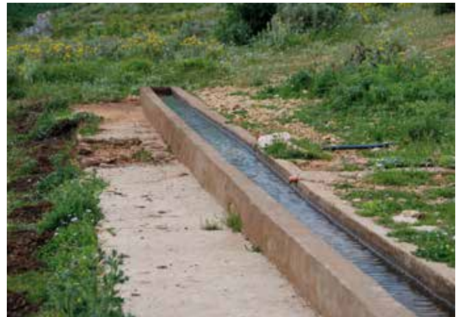
Abbildung 65: Betonierter Tränketrog – der Vorplatz des Tränkeplatzes ist betoniert, um Morastbildung zu vermeiden. (© Stefan Hellebart)
