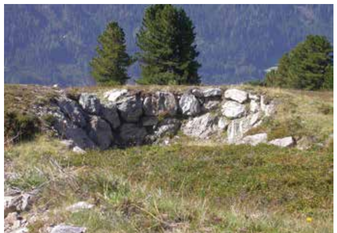
Abbildung 86: Das Retentionsbecken dient dazu, Oberflächenwasser zu speichern; somit kann das Wasser zu einem späteren Zeitpunkt zur Versickerung gebracht werden. (© Stefan Hellebart)
