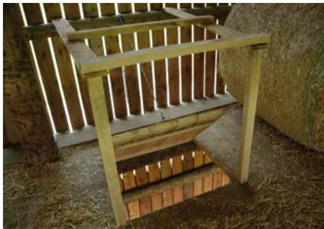
Abbildung 18: Abwurffluken sind mit Absturzsicherungen zu versehen. (© Susanne Schönhart)
