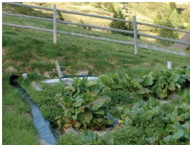
Abbildung 8: Pflanzenkläranlage auf der Alm (© Susanne Schönhart)
