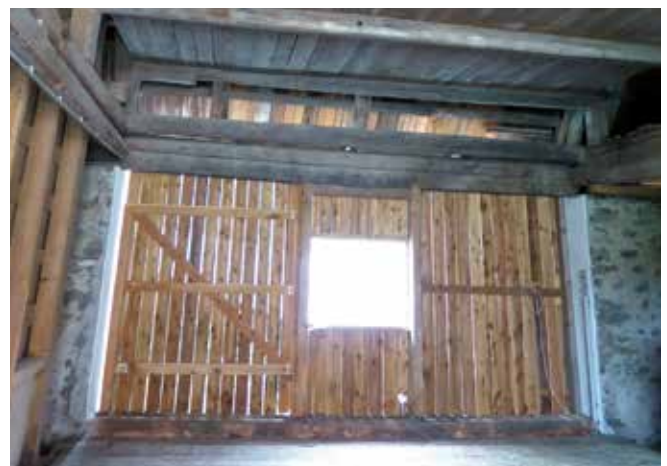
Abbildung 17: Bei erhöht liegenden Arbeitsplätzen ist es wichtig, dass die Bodenbeläge entsprechend dimensioniert sind. (© Susanne Schönhart)
